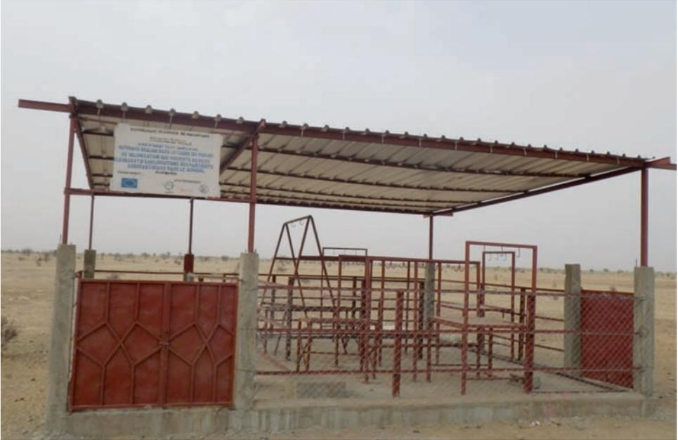
Les aires d'abattages sont raccordées à une source d'eau servant de réservoir d'eau, élément indispensable pour assurer l'hygiène et l'assainissement de l'ouvrage. Elles sont composées de 04 secteurs :
