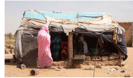
Tentes fermées par des barbelés, dalle en béton et toit en « zinc » ou en tissu, héritées de la culture nomade
