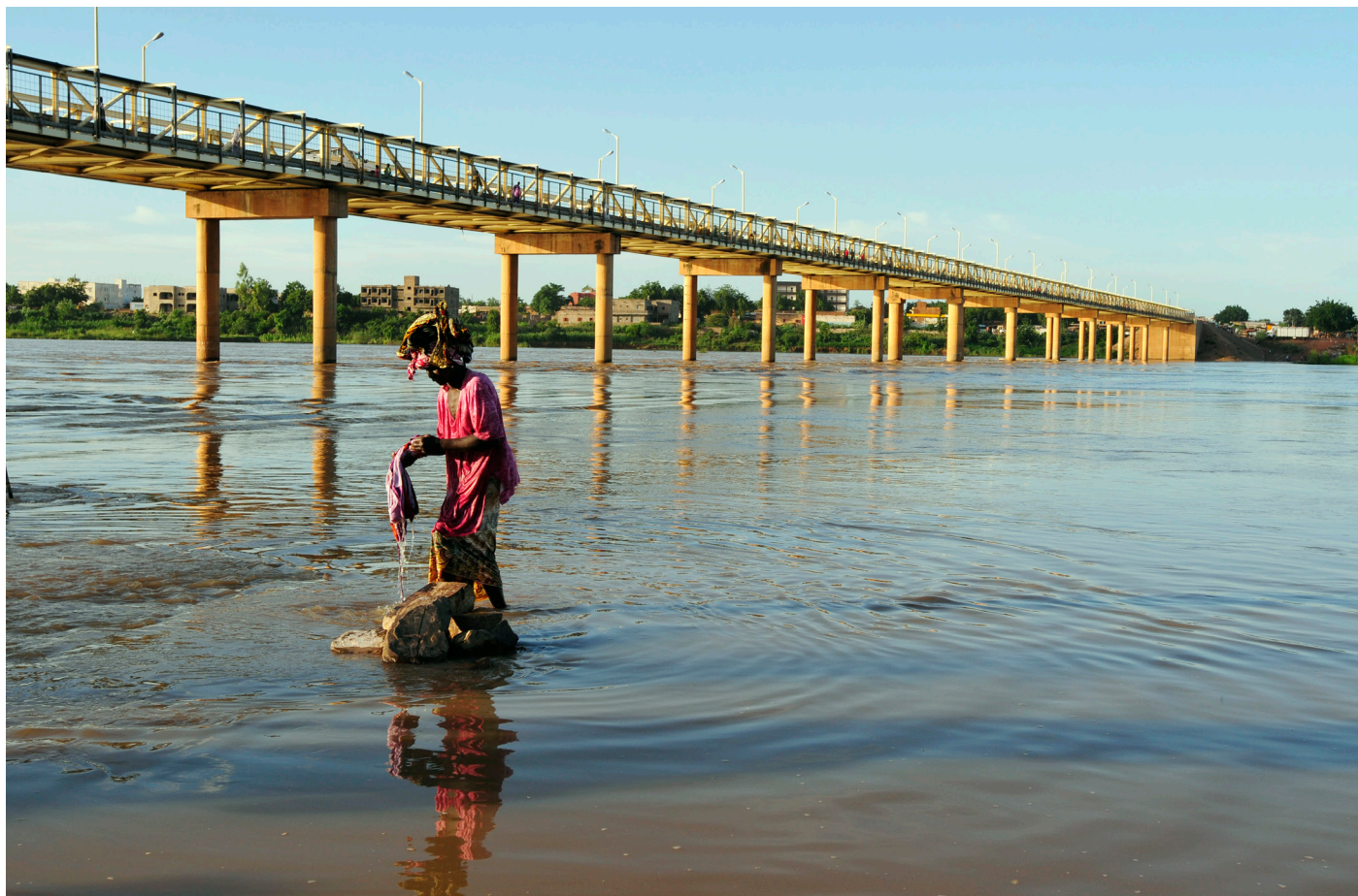
Vue du pont de la ville de Kayes - Octobre 2010.JB Russel
