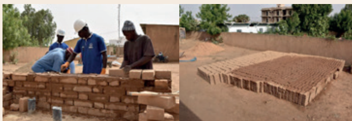
Production des briques de BTC sur un chantier
