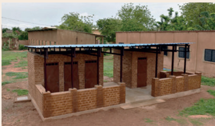
Exemple de blocs sanitaires réalisés à Bakel
