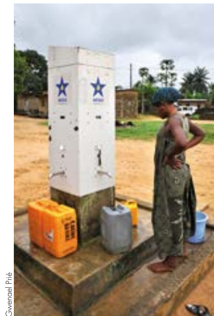
Borne-fontaine Sofoco avec carte magnétique prépayée en RDC.
