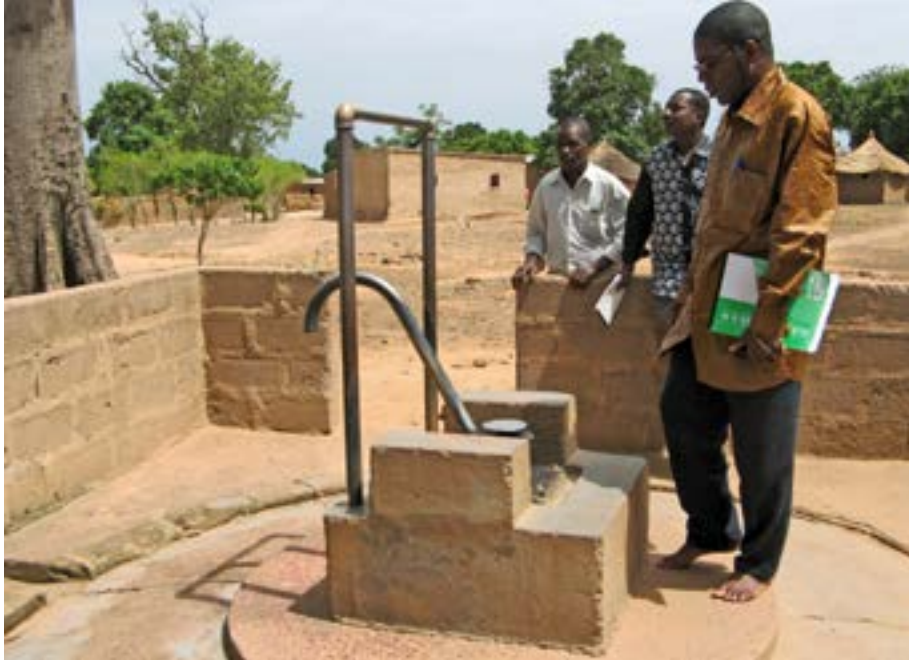
Pompe hydraulique dans la région de Bobo-Dioulasso.
