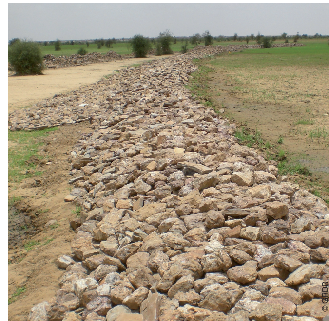
Diguette en pierre dans le Guidimakha
