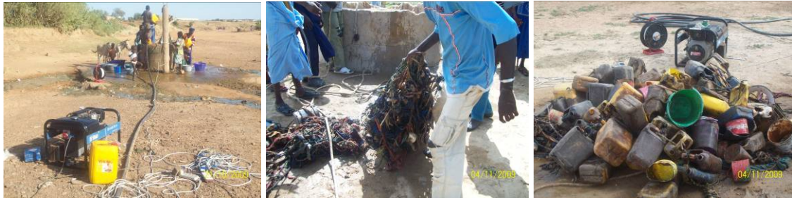
Photos de la vidange d'un des puits de Hassi Chegar
