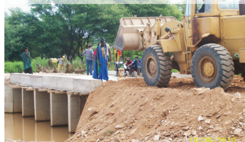
Réalisation des remblais
