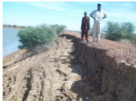
Les périmètres sont réalisés sur le lit majeur du fleuve le long des berges ; l'inondation de ces périmètres se fait par la rupture de la digue de protection qui totalement érodé par les crues périodiques du fleuve.
