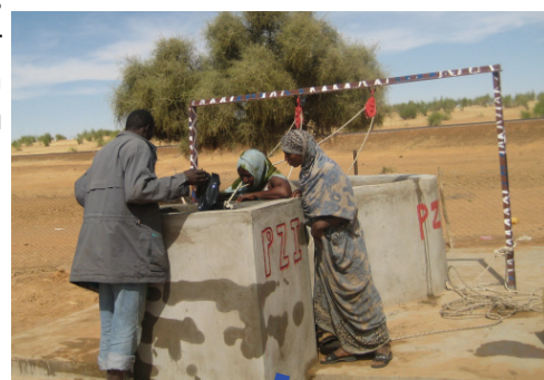
Coulage de la dalle
