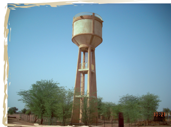
Photo 1: château d'eau de Gory
